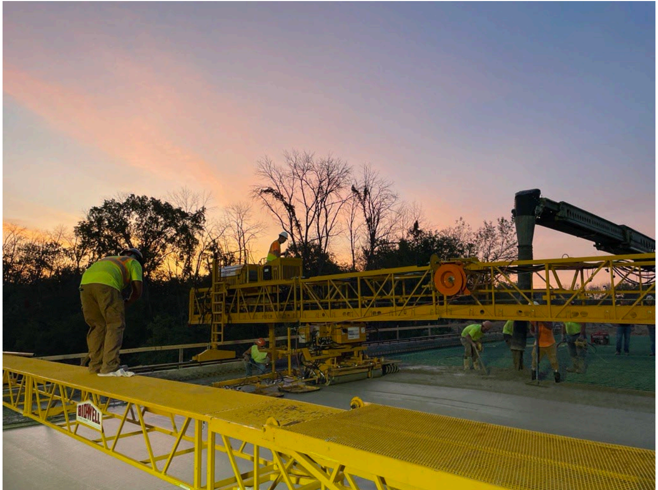
Concrete Deck Pour
